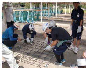
鉄筋工：鉄筋結束の基礎を学習
