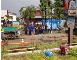
・道路工事では杭打ちを見学
