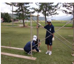
とび工：足場の水平をレーザーで検測
